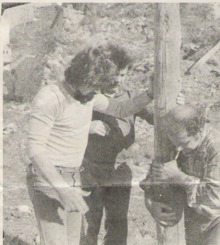
Tonino Russo (in primo piano), Giuseppe Crivella e Franco Iosella mentre costruiscono il capannone dell'ex "Comunità di Intavolata".
